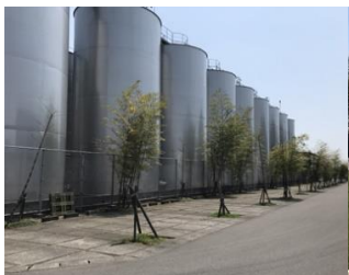
⑤霧の蔵ホール前駐車場
